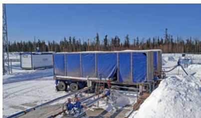
Рис. 1. Работа мобильной газосепарационной установки с использованием манифольда
