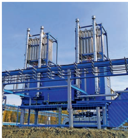
АВТОНОМНЫЙ ИСТОЧНИК ПИТАНИЯ НА БАЗЕ СВОБОДНОПОРШНЕВЫХ ДВИГАТЕЛЕЙ СТИРЛИНГА ДЛЯ МОДУЛЯ АВТОМАТИЗИРОВАННОЙ ТЕХНОЛОГИЧЕСКОЙ ОБВЯЗКИ СКВАЖИН (СЛЕВА) И АВТОНОМНЫЙ КОМПЛЕКС ЭЛЕКТРОСНАБЖЕНИЯ АКЗ-100/500-001 ДЛЯ ОБОРУДОВАНИЯ МАЛОЙ МОЩНОСТИ (СПРАВА)
