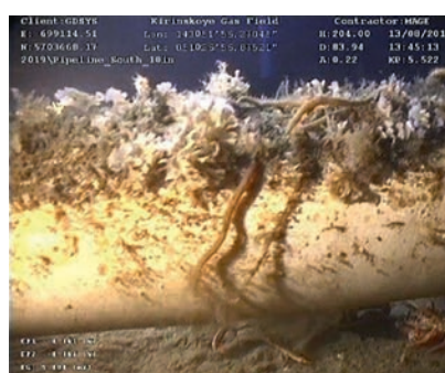
Рис. 6. Свободные пролеты трубопровода-шлейфа
