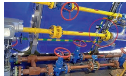
Рис. 2. Сужающее устройство с дифманометром
